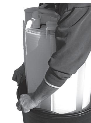
1. Commencer par l'arrière (côté opposé des raccords), placer le joint torique autour de la lèvre du boîtier du filtre et le ramener vers soi en le tenant entre le pouce et l'index
